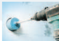
Kernbohrung in der Wand
